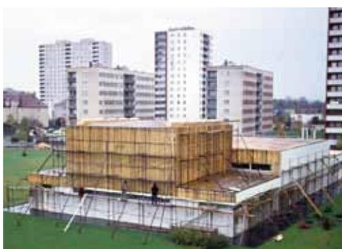
1977: Erste Sanierungsarbeiten am Dach und Wärmedämmung
